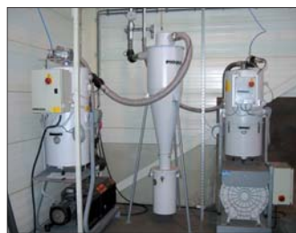
Vacuümgroepen met stofafscijders voor pneumatisch transport van de grondstoffen en additieven.
